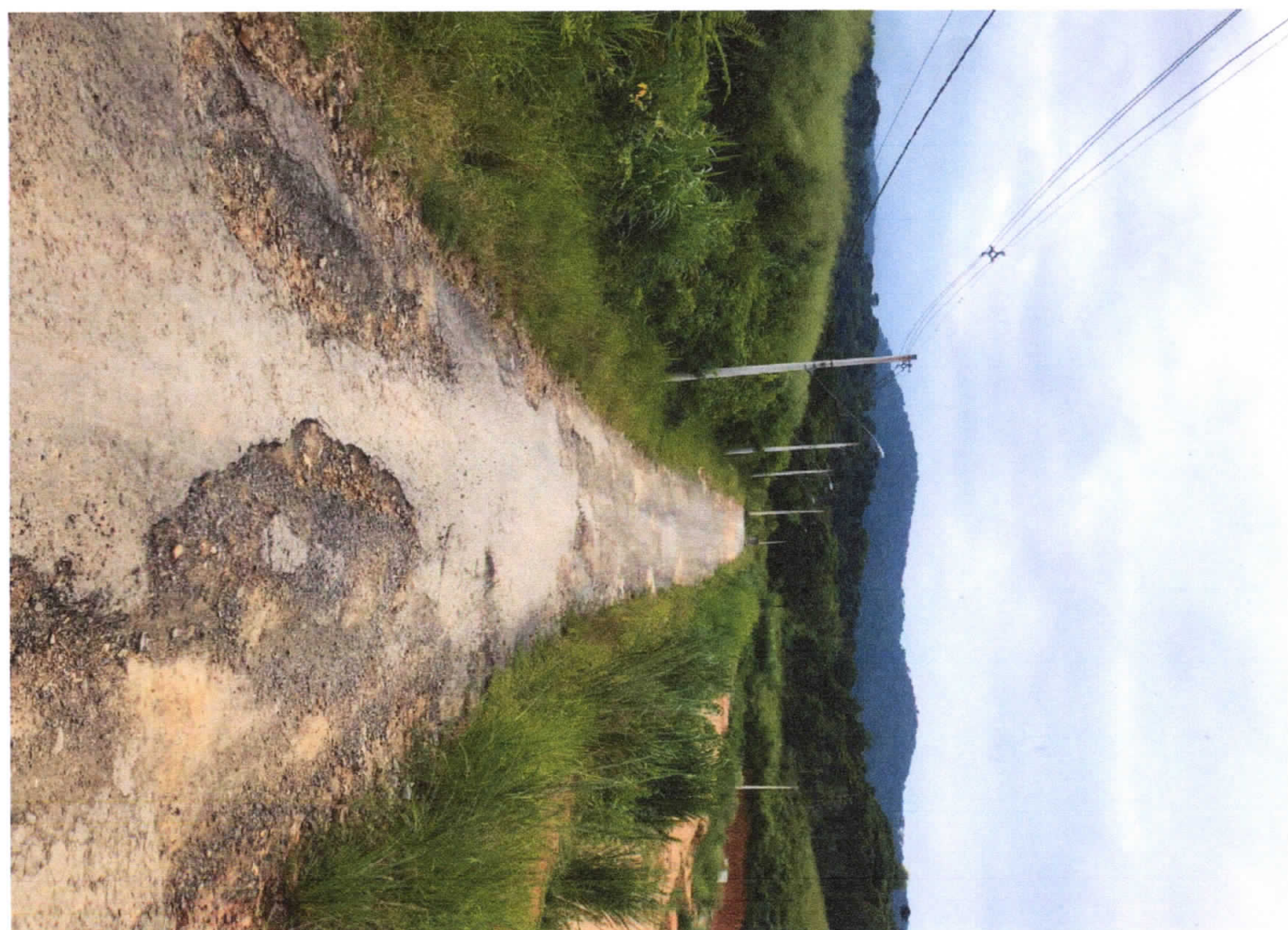
Ina. 164/22 - Pavimentação asfáltica Vila Formosa
