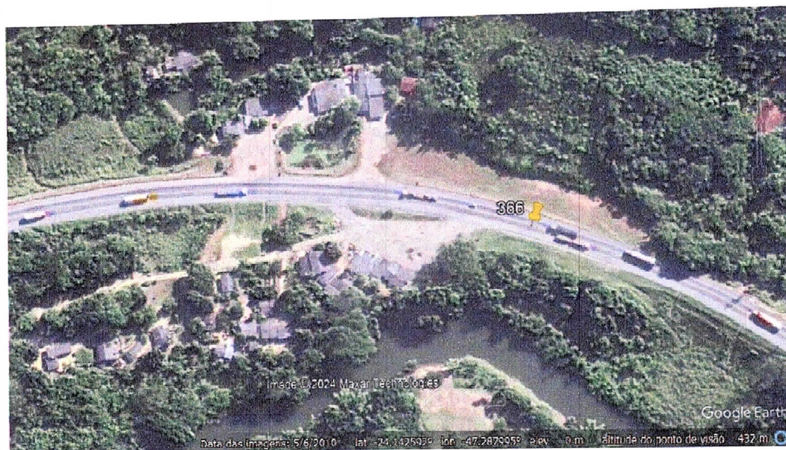
Imagem 3 - Vista aérea em 05/06/2010 – Antes da execução das Melhorias de Acessos
