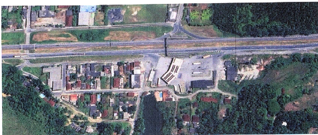
Imagem 1- Retorno em desnível Km 369+400
