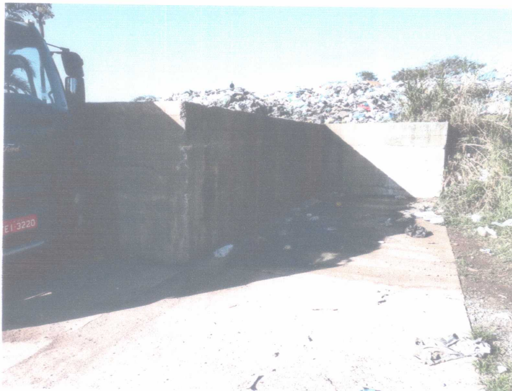
Figura 1 - ÁREA DO TRANSBORDO DE LIXO LOCALIZADA NO PÁTIO DA PEDREIRA MUNICIPAL – DATA DA FOTO 29/08/2018
