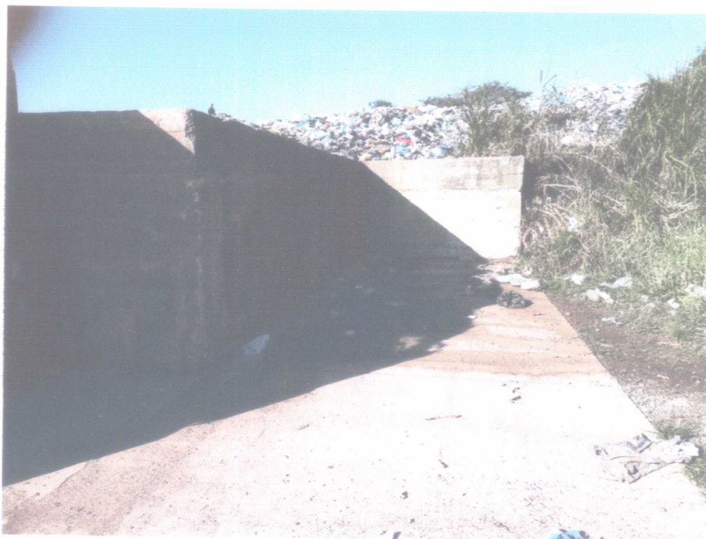
Figura 7- ÁREA DO TRANSBORDO DE LIXO LOCALIZADA NO PÁTIO DA PEDREIRA MUNICIPAL – DATA DA FOTO 29/08/2018
