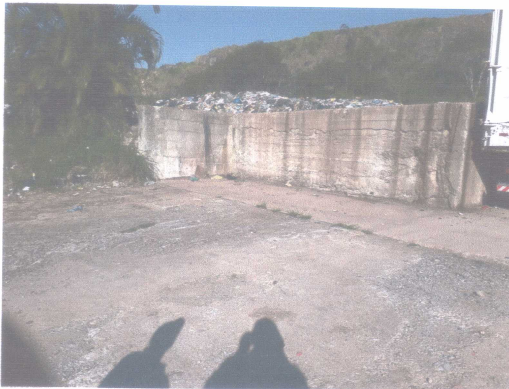
Figura 4 - ÁREA DO TRANSBORDO DE LIXO LOCALIZADA NO PÁTIO DA PEDREIRA MUNICIPAL – DATA DA FOTO 29/08/2018
