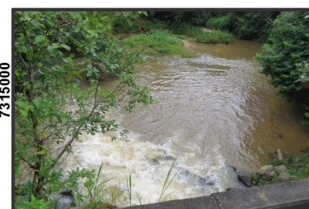
Vista da margem oposta do rio do Faú, sobre a ponte. Conforme relatos, este trecho apresenta histórico de inundação com comprometimento do acesso às residências do bairro Nossa Fazenda.
