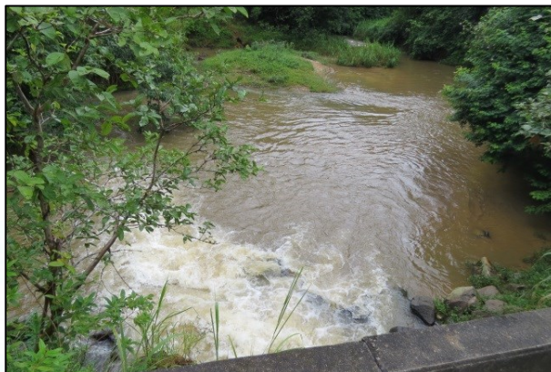
Foto 6. Vista da margem oposta do rio do Faú, sobre a ponte. Conforme relatos, este trecho apresenta histórico de inundação com comprometimento do acesso às residências do bairro Nossa Fazenda.
