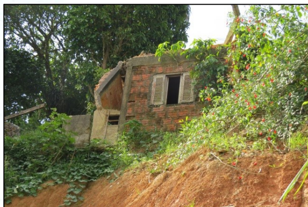
FOTO 16. Detalhe de residência no topo do morro da Sudelpa, parcialmente destruída por deslizamento de terra. Nota-se que o processo permanece ativo neste local, ameaçando as edificações abaixo deste ponto.
