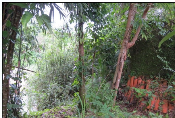
FOTO 48. Distância entre o muro da residência e o talude marginal com o rio Bananal. O último processo de inundação, neste ano, atingiu esta cota.
