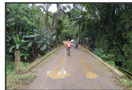
Ponte de acesso às residências no bairro Barra Funda, à montante do rio Bananal.
