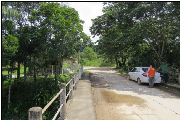
FOTO 55. Ponte sobre o rio São Lourenço no bairro Engenho. Notar ao fundo a construção, próxima ao talude marginal do rio.
