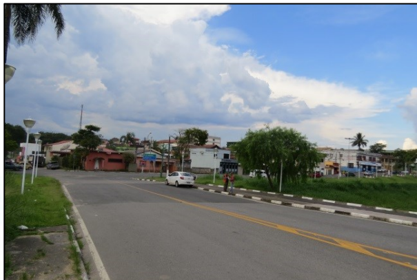
FOTO 40. Vista da região central sujeita a inundação. Neste local o acesso à cidade fica prejudicado, além das edificações afetadas.
