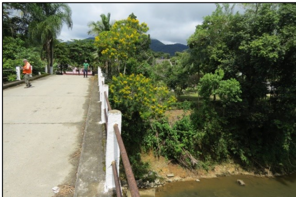
FOTO 51. Ponte sobre o rio São Lourenço no bairro Pedro Barros. Notar ao fundo as construções do bairro, próximas ao talude marginal do rio.
