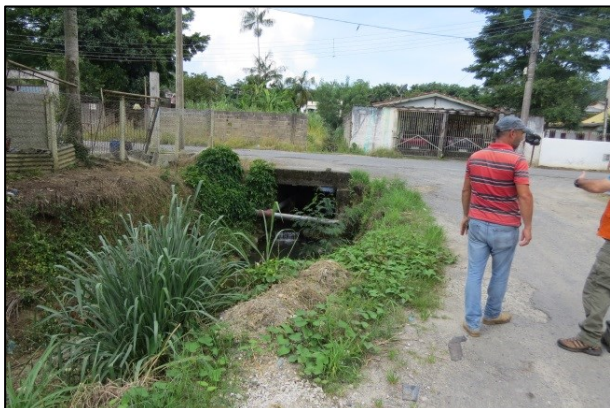
FOTO 21. Foto do córrego Ubirajara ao fim da rua Santa Rita. Notar a proximidade da rua e a ponte ali existente.
