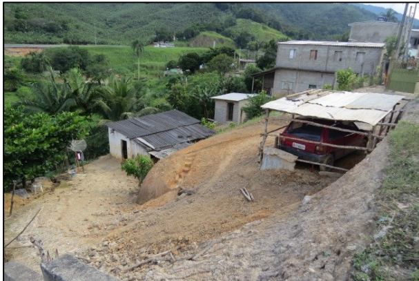
FOTO 33. Padrão de ocupação na rua Adoniran Barbosa. Notar a proximidade das casas aos taludes de corte.
