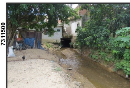
Detalhe das construções sobre o córrego Ubirajara.
