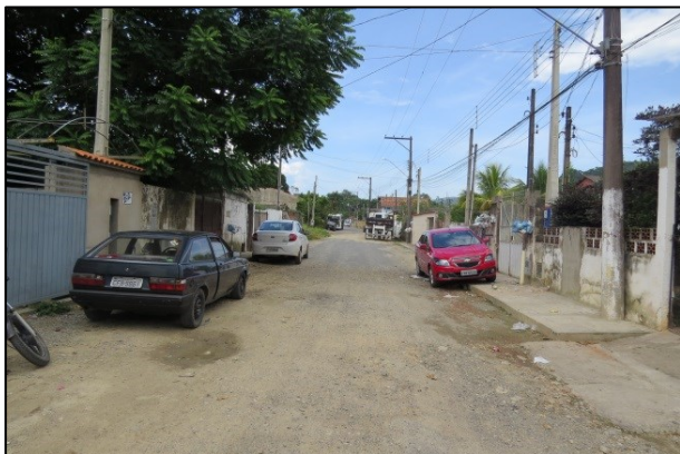
FOTO 17. Vista geral da rua Santa Rita, em trecho sujeito à inundação. Notar o padrão das ocupações, falta de sistema de drenagem de águas pluviais e pequeno caimento da via.
