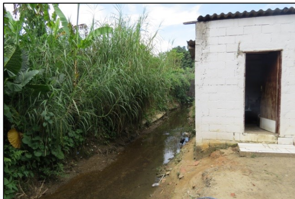
FOTO 18. Proximidade da moradia ao córrego Ubirajara. Notou-se ainda a vegetação, assoreamento, lixo e lançamento de esgotos diretamente no corpo d'água.
