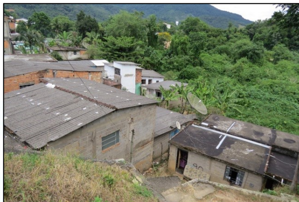
FOTO 44. Detalhe da ocupação urbana próxima ao córrego (ao fundo das casas), com acesso pela estrada do Faú. Este local sofre inundação deste corpo d'água e do rio São Lourenço, onde ambos se encontram.
