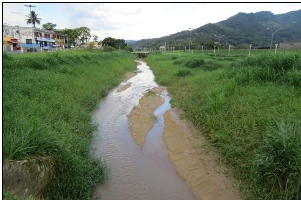
FOTO 39. Córrego entre a avenida Washington Luis e a rodovia Régis Bitencourt no centro de Miracatu. Notar a vegetação, assoreamento e lixo no corpo d'água.
