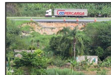
Vista geral de escorregamento de talude da rodovia Régis Bitencourt em direção à rua Vinicius de Moraes.
