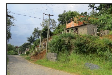
Ocupações de meia encosta no morro da Sudelpa, em sua porção lateral. Notar a modificação do relevo natural pelas construções no local.
