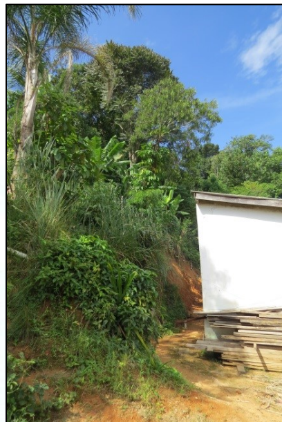
FOTO 14. Detalhe do entorno da residência atingida. Nota-se a existência de tubulação de esgoto rompida no talude, a declividade e vegetação do local.
