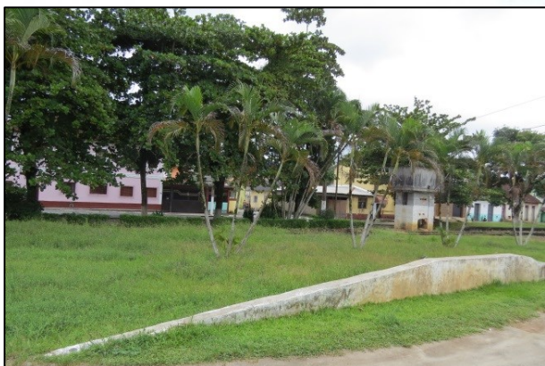
FOTO 53. Edificações no bairro Pedro Barros. Estas moradias encontram-se sujeitas ao processo de inundação do rio São Lourenço, neste local.
