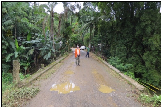
FOTO 49. Ponte de acesso às residências no bairro Barra Funda, à montante do rio Bananal. Neste local o escoamento do caracteriza-se pela alta energia, devido às declividades do relevo.
