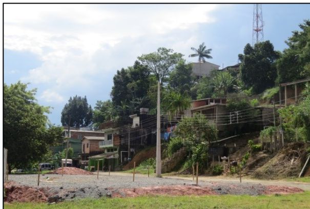
FOTO 10. Padrão construtivo das residências no local. Notar a amplitude e declividade do terreno.
