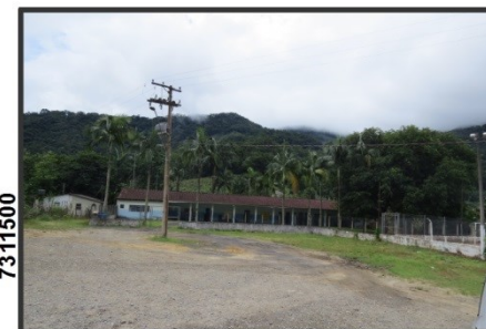
Vista da escola e residência sujeitas ao processo de inundação do rio Quati. Este rio situa-se entre 20 e 30 metros ao fundo dessas construções
