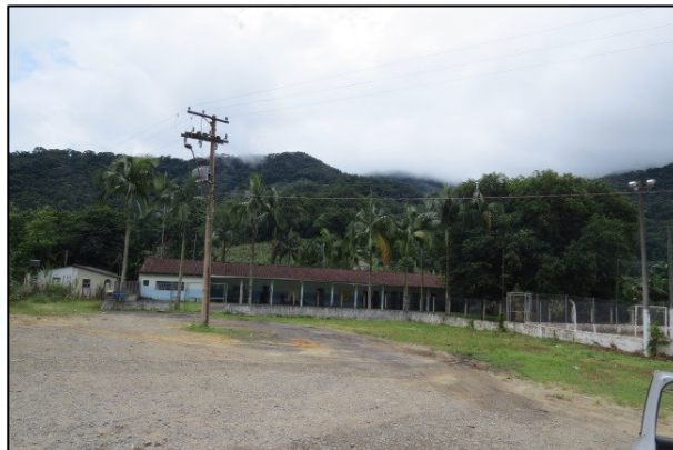
FOTO 38. Vista da escola e residência sujeitas ao processo de inundação do rio Quati. Este rio situa-se entre 20 e 30 metros ao fundo dessas construções.
