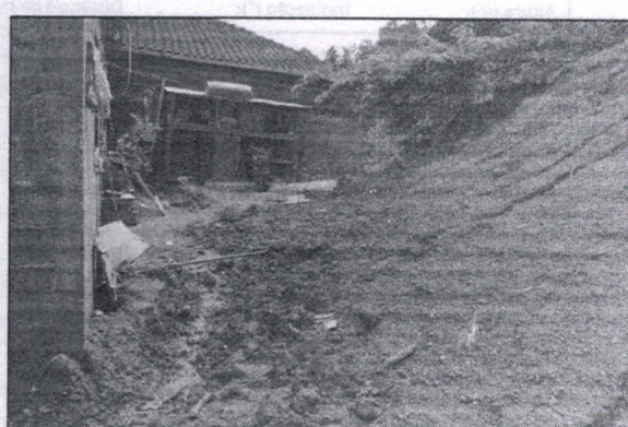
FOTO 32. Detalhe do escorregamento de talude de corte na rua Vinicius de Moraes. Notar a surgência d'água na base.
