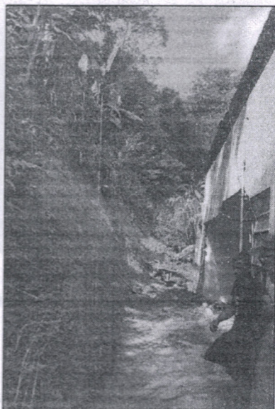
FOTO 13. Residência atingida por escorregamento de terra no morro da Sudelpa. Notar que, apesar do pequeno porte do evento, a parede dos fundos da residência foi destruída parcialmente. Não houve feridos.
