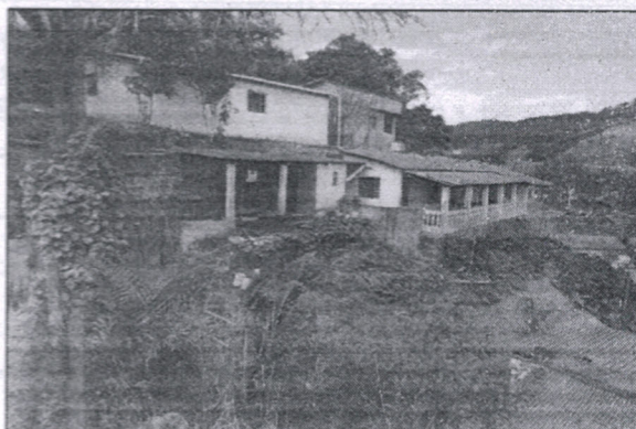
FOTO 29. Padrão de ocupação de encosta nos bairros Ubirajara e Jardim Iolanda, entre as ruas Vinicius de Moraes e Adoniran Barbosa. Notar a proximidade das casas aos taludes de corte.
