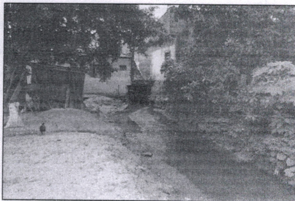
FOTO 20. Detalhe das construções sobre o córrego Ubirajara. Este local é um ponto de "estrangulamento" do escoamento devido ao estreitamento da seção do córrego, potencializando a inundação.
