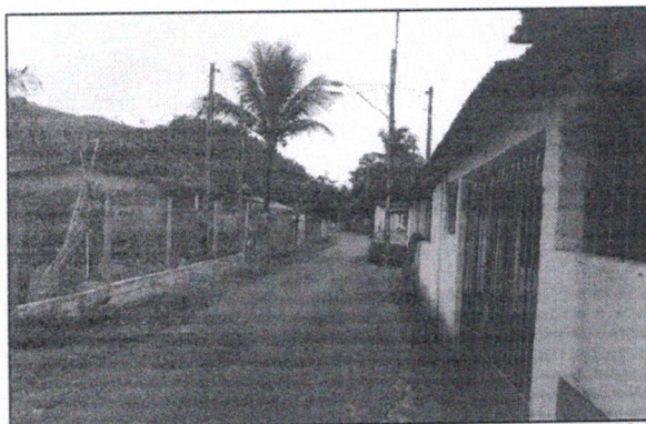
Foto 3. Aspecto das moradias na rua principal do bairro. O rio São Lourenço margeia o fundo das residências à esquerda da foto.
