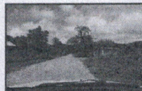
Padrão de ocupação do local. As moradias situam-se na via de acesso ao bairro, na planície de inundação do rio São Lourenço.
