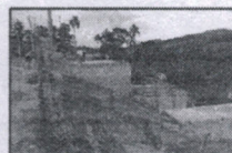
Novas moradias ao fim da rua Adoniran Barbosa. Nota a precariedade do sistema de drenagem na encosta.
