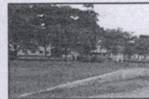
Edificações no bairro Pedro Barros. Estas moradias encontram-se sujeitas ao processo de inundação do rio São Lourenço, neste local.
