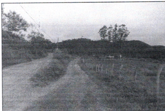
Foto 1. Vista do acesso na estrada do Faú ao bairro Beira Rio. Observar que o terreno apresenta cotas inferiores às da estrada de acesso.
